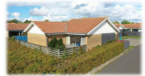
Foto af facade mod have - før renovering
