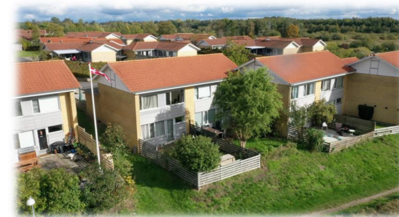
Foto af facade mod have - før renovering
