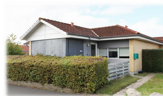
Foto af facade mod vej - før renovering
